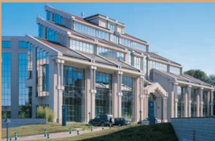
Architect: M&C Marijnissen
